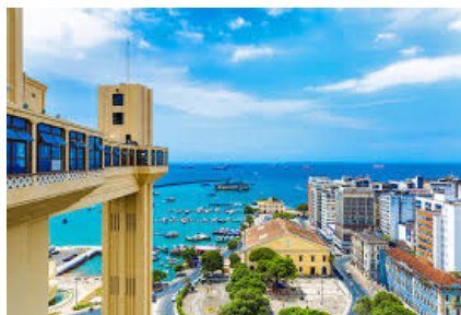
Oben: Elevador (Aufzug) auf der linken Seite.
